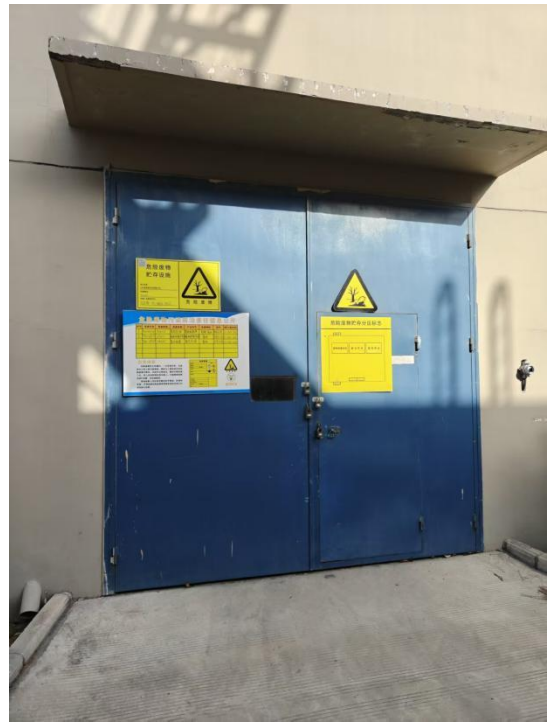
危废仓库（外部）
