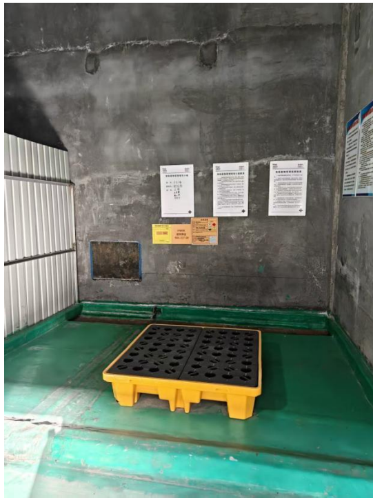
危废仓库（内部）
